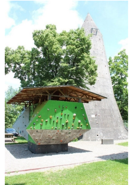
Kletterbunker der GSW Gießen, Quelle: ISP
